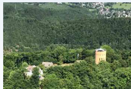
Die Ginsburg von oben und viel Geld des Bundes zur Sanierung.
